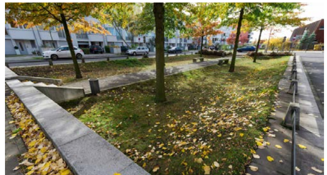
Mulden-Rigolen-System im Straßenraum der Rummelsburger Bucht © Berliner Regenwasseragentur
