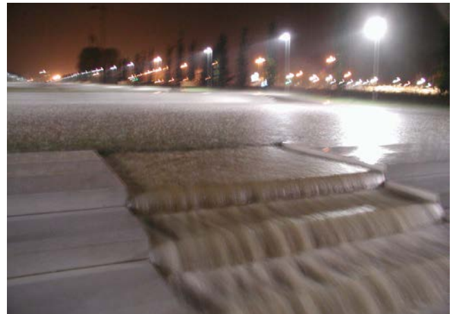
Gezielte Ableitung eines Starkregenereignis über Treppenanlage Scharnhäuser Park, Ostfildern © Ramboll Studio Dreiseitl
