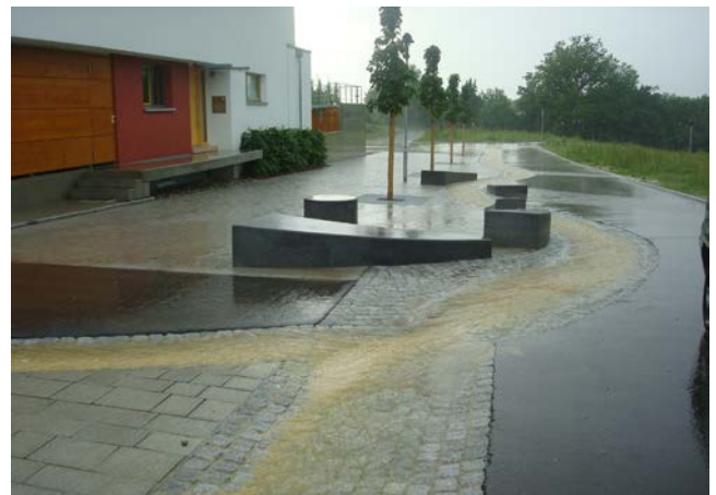
Ableitung eines Starkregenereignis über gepflasterte Rinne Sonnensiedlung Esslingen-Egert © Ramboll Studio Dreiseitl
