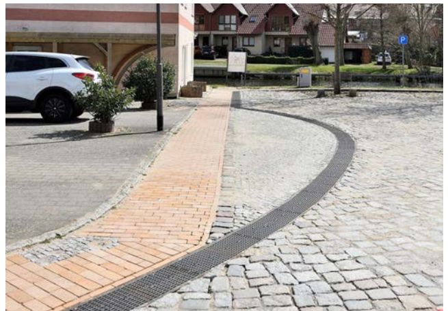
Kastenrinne eingebettet in Pflasterung Wohngebiet in Lübz © Hydrotec
